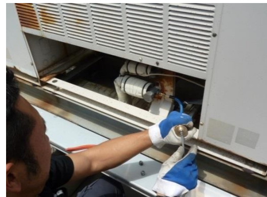
専用注入器で薬剤を注入する
